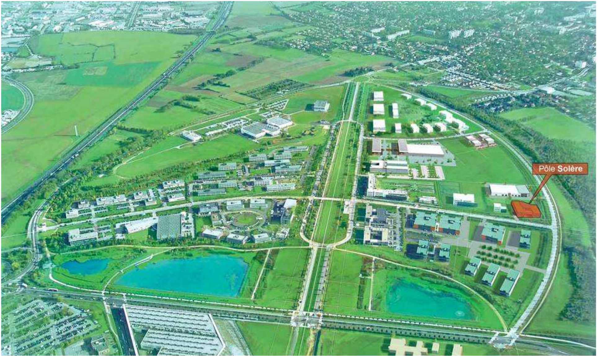
Vue aérienne du Parc Technologique de Saint-Priest ( Aménageur: SERL)
